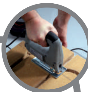
docinanie płyt systemowych na wymiar cutting system panels for a specific dimension
