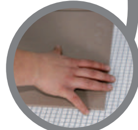
montaż płytek, jako elementu podłogi docelowej assembly of tiles, as an element of the target floor
