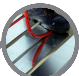
montaż pętli rurociągu assembling the pipeline loop
