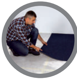
układanie podłogi docelowej z wykładziny (opcja) laying target floor from lining (option)
