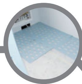
układanie podkładu pod podłogi pływające (opcja, gdy zachodzi taka konieczność) laying foundation for floating floors (option when necessary)
