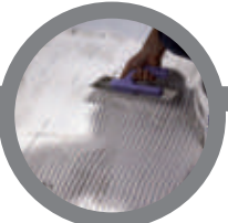
układanie warstwy zaprawy klejowej laying a layer of adhesive mortar
