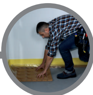
układanie płyt systemowych element skrzyński laying system panels, twisting element
