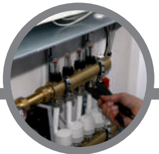
podłączenie rurociągów do rozdzielacza connecting pipelines to the distributor
