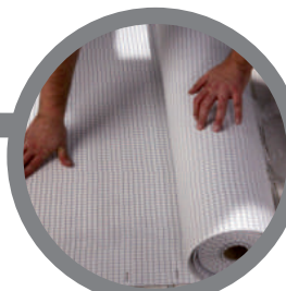
układanie maty uzbrojonej w siatkę z włókna szklanego na podłożu z zaprawy klejowej laying mat reinforced with netting from glass fiber on base from adhesive mortar
