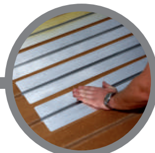
układanie paneli transmisyjnych z blachy aluminiowej laying transmission panels from aluminum sheet
