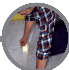
oklejenie dylatacji pomiędzy płytami Top taśmą papierową covering expansion joints between Top panels with paper strip
