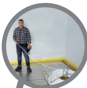
przygotowanie rozwijaka z rurą preparation of pipelayer
