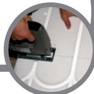
docinanie płyt systemowych na wymiar cutting system panels for a specific dimension
