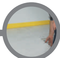
układanie płyt podkładowych Top laying ground panels Top
