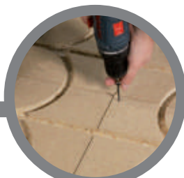
montaż płyt do podłoża assembling panels to the base
