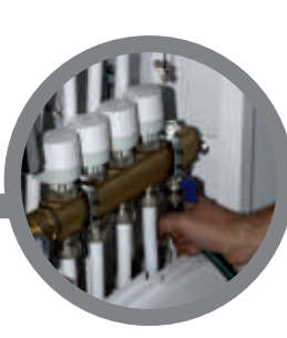
plukanie rurociągu, napełnianie instalacji i próba ciśnienia rinsing the pipeline, filling the system and pressure test
