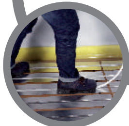
montaż pętli rurociągu w panelach transmisyjnych assembly of pipeline loop in transmission panels transmission
