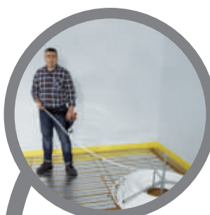
przygotowanie rozwijaka z rurą preparation of pipelayer
