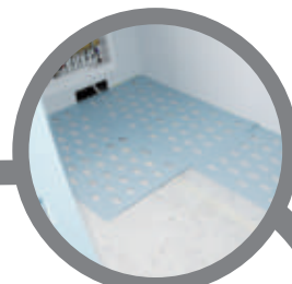
układanie podkładu pod podłogi pływające (opcja, gdy zachodzi taka konieczność) laying foundation for floating floors (option when necessary)
