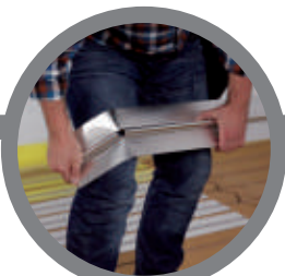
dopasowanie długości panelu transmisyjnego z blachy aluminiowej adjusting length of transmission panel from aluminum sheet
