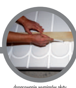
dopasowanie wymiarów płyty adjusting panel's dimensions
