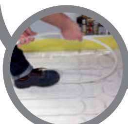
montaż pętli rurociągów assembling the pipeline loop
