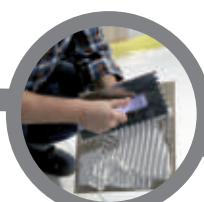
nakładanie zaprawy klejowej na płytki applying adhesive mortar on tiles
