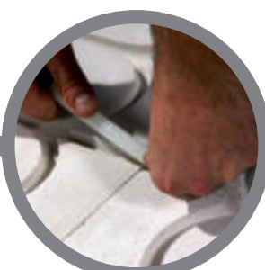
zabezpieczenie paneli przed przesunięciem przez montaż odcinków rury protecting panels against shifting by assembling pipe sections
