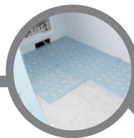
układanie podkładu pod podłogi pływające (opcja, gdy zachodzi taka konieczność) laying foundation for floating floors (option when necessary)
