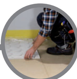
układanie płyt systemowych element skrzywny laying system panels, twisting element
