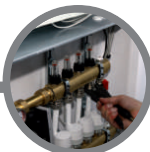
podłączenie rurociągu do rozdzielacza connecting pipelines to the distributor
