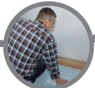
układanie podłogi docelowej z paneli (opcja) laying target floor from panels (option)
