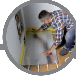
układanie panelu podrozdzielczego z blachy aluminiowej laying the panel under the distributor from aluminum sheet
