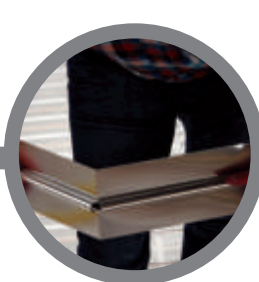
dopasowanie długości panelu transmisyjnego z blachy aluminiowej adjusting length of transmission panel from aluminum sheet
