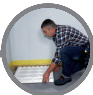
układanie płyt systemowych element skretny laying system panels, twisting element
