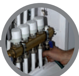
plukanie rurociągu, napełnianie instalacji i próba ciśnienia rinsing the pipeline, filling the system and pressure test
