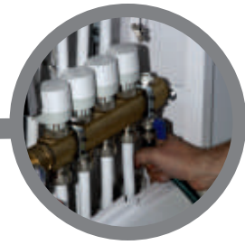
plukanie rurociągu, napełnianie instalacji i próba ciśnienia rinsing the pipeline, filling the system and pressure test
