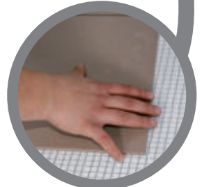
montaż płytek, jako elementu podłogi docelowej assembly of tiles, as an element of the target floor
