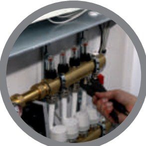
podłączenie rurociągów do rozdzielacza connecting pipelines to the distributor
