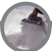
układanie warstwy zaprawy klejowej laying a layer of adhesive mortar
