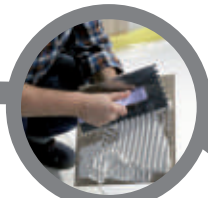
nakładanie zaprawy klejowej na płytki applying adhesive mortar on tiles
