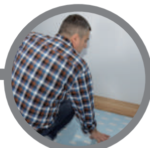
układanie podłogi docelowej z paneli (opcja) laying target floor from panels (option)
