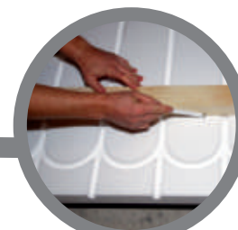
dopasowanie wymiarów płyty adjusting panel's dimensions
