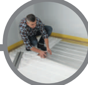
układanie paneli transmisyjnych z blachy aluminiowej laying transmission panels from aluminum sheet
