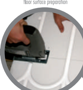
docinanie płyt systemowych na wymiar cutting system panels for a specific dimension
